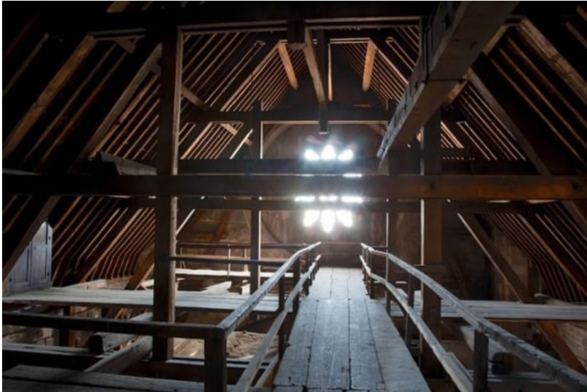
Párizsi Notre Dame székesegyház gótikus fedélszék – belső nézet https://archeologia.hu/gotika-a-stilus-ami-tuzben-szuletett
